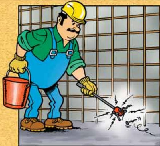
NETTOYEZ LE COFFRAGE À L'AIDE D'UN OUTIL AIMENTÉ ET D'EAU.
