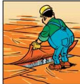
ÉVITEZ-LES GRÂCE À UNE BONNE PROTECTION À L'AIDE D'UN PRODUIT DE CURE... OU EN MAINTENANT LE BÉTON HUMIDE EN LE RECOUVRANT D'UN FILM PLASTIQUE.
