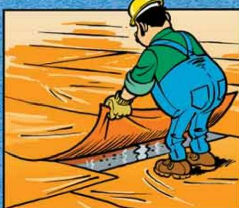
POSEZ DES NATTES OU DES FILMS PLASTIQUES AVEC SUFFISAMMENT DE RECOUVERTEMENTS SUR LES BORDS. POSEZ DES CALES S'IL Y A DU VENT. PENSEZ À METTRE ASSEZ DE POIDS SUR LES BORDS...
