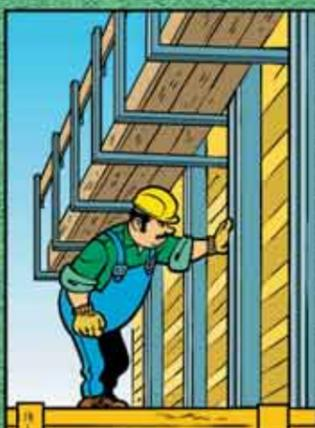
CONTRÔLEZ L'ÉTANCHÉITÉ DU COFFRAGE ET DES JOINTURES.
