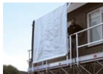
Travaux avec écrans
